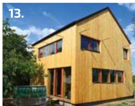
Nový Přerov - 2016 - dřevostavba
