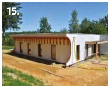
České Budějovice - 2016 - dřevostavba
