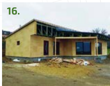
Česká Kubice - 2018 - dřevostavba
