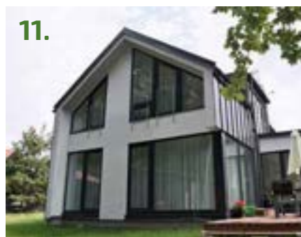
Račín - Ždírec nad Doubravou - 2017 - dřevostavba
